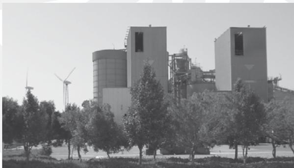
Construite en 2001, cette usine de broyage et de conditionnement possède une capacité annuelle de 250 000 tonnes. Afin de satisfaire les besoins croissants en ciment des Provinces du Sud, celle-ci a été portée à 500 000 tonnes en 2010. L'usine a réduit sa facture énergétique par l'utilisation de 60 % de l'énergie éolienne produite par son propre parc éolien.
