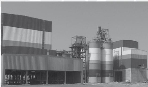
Mis en service en 2014, le nouveau centre de broyage de Jorf Lasfar est équipé de deux ensacheuses automatiques, d'une ligne pour le chargement automatique de camions, ainsi que de deux lignes de chargement manuel de camions et dispose d'une capacité de stockage de ciment de 4 000 tonnes, d'une capacité de broyage de 70 t/H et d'une capacité annuelle de production de 450 000 tonnes.
