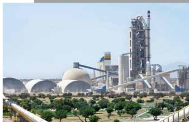
chage et de chargement mécanisé de haute performance (8 000 t/j) et d'un atelier de palettisation. Les technologies déployées dans cette usine lui confèrent des performances énergétiques et environnementales des plus économiques. Il est à signaler que c'est une des rares usines au monde à être dotée d'une technologie de cogénération consistant en la production d'électricité à partir de la chaleur résiduelle des gaz de four traditionnellement rejetés dans l'atmosphère.
